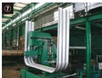
工程⑦ ▶ 両側曲げ完了。ラジアルガレージの基となる1スパンの完了です。
