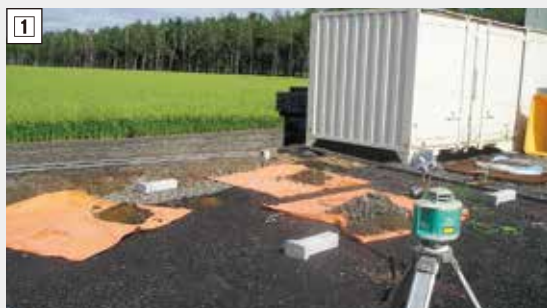
工程① ▶ ガレージの組立で一番大切で大変な根拠作業です。
