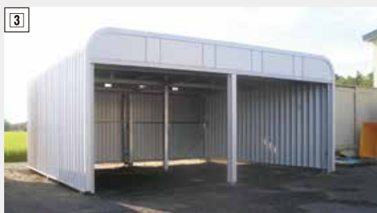
工程③ ▶ 完成内部
