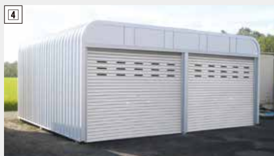
工程④ ▶ 完成(工事は一日で完了しました。)
