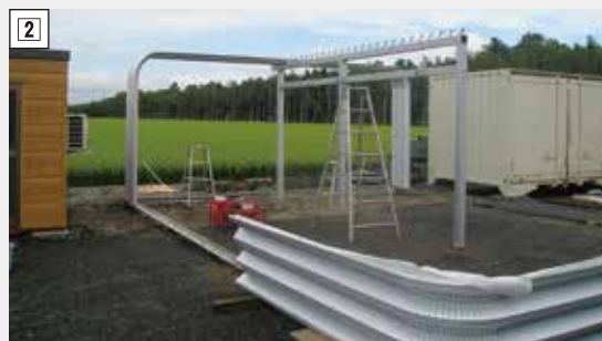
工程② ▶ 中柱をたて、1スパンのR曲げルーフデッキをかけた所です。
